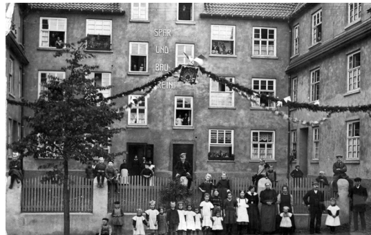
Das 1912 durch den Spar- und Bauverein errichtete „Hufeisen“ Hagener Straße 123-127
