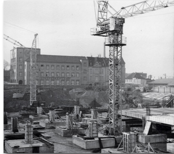
Karstadt-Baustelle 1966 Blick Richtung Sparkasse © Archiv der Sparkasse Iserlohn
