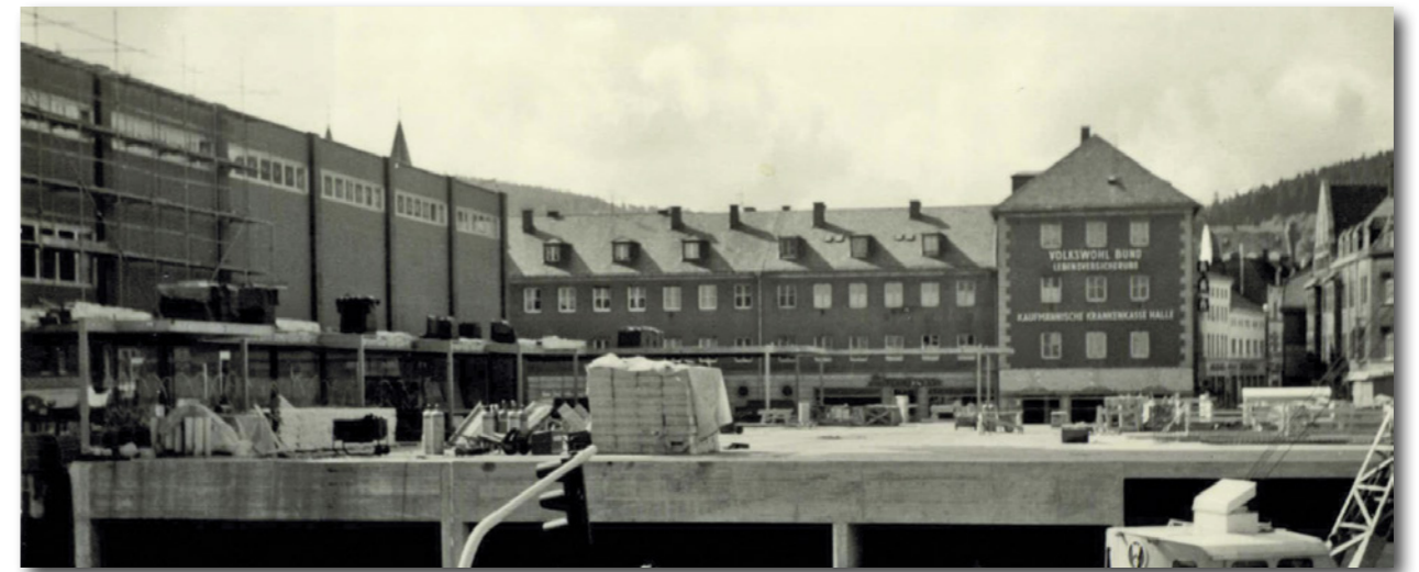
Karstadt-Baustelle 1960er Jahre
