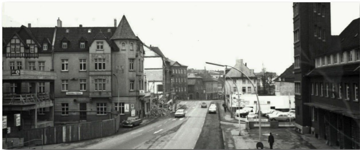
Luisenstraße Ende der 1960er Jahre Am rechten Bildrand ist das Feuerwehrgerätehaus (heute Rathaus I) zu erkennen.
