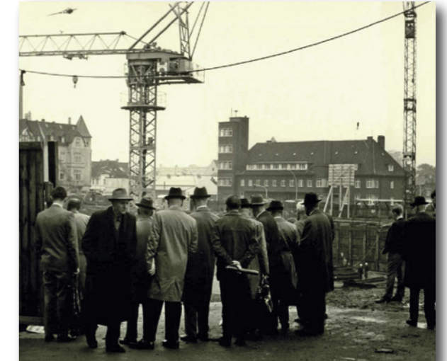
Großes Interesse an der Karstadt-Baustelle 1966 © Elisabeth Peschel
