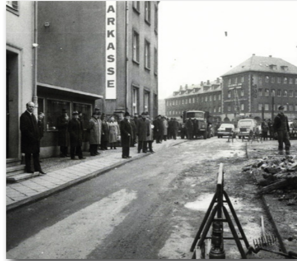
Abriss der Häuser in der Grabenstraße für den Neubau der Rhein-Ruhr-Bank 1954 Blick Richtung Schillerplatz © Archiv der Sparkasse Iserlohn
