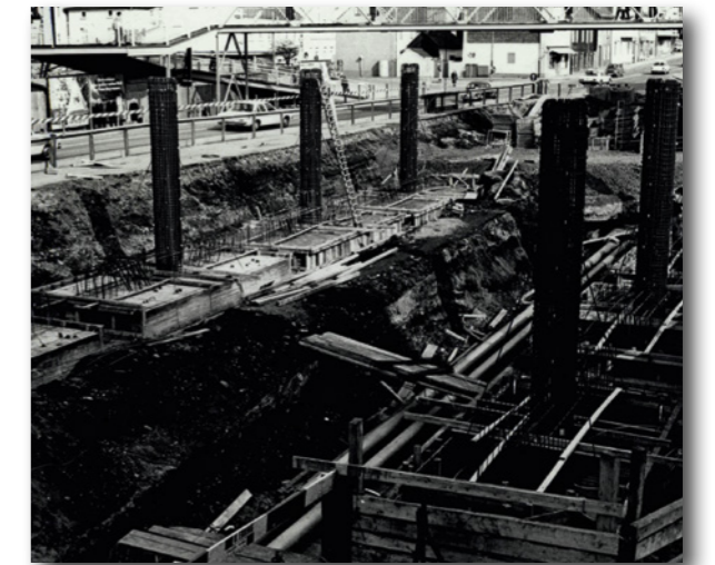
Neubau Schillerplatzbrücke – Verlegung der Fernwärmeleitung März 1973 Blick von der Sparkassentreppe © Stadtarchiv Iserlohn
