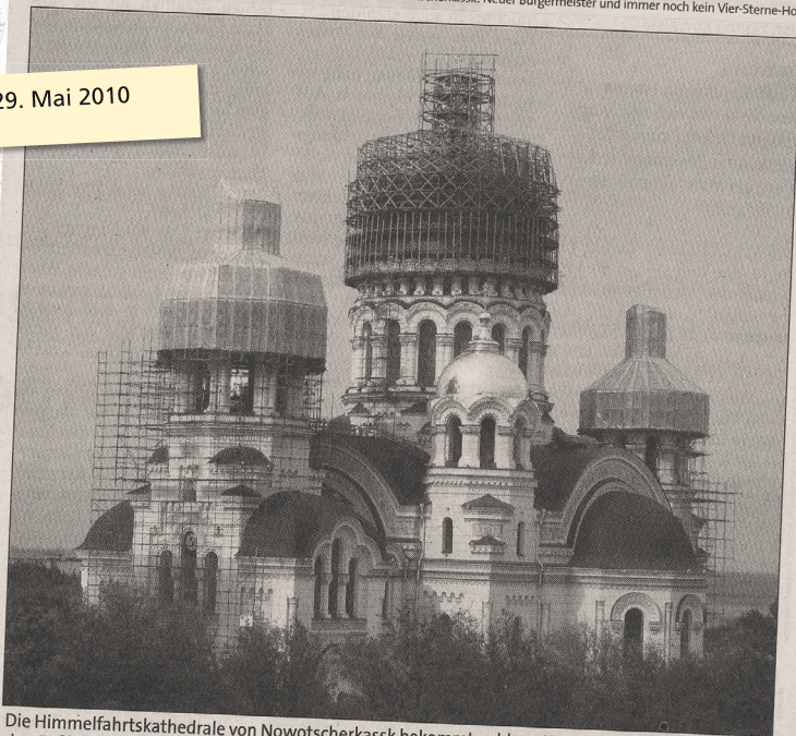
Die Himmelfahrtskathedrale von Nowotscherkassk bekommt goldene Kuppeln und obendrein sogar eine Fußbodenheizung, da von unten eindringende Feuchtigkeit die Wandgemälde bedroht.
