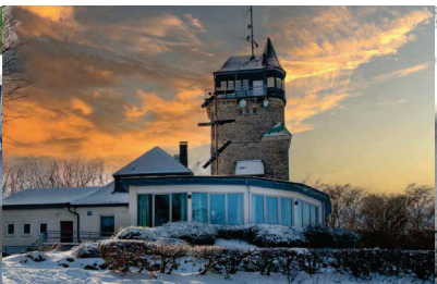
Стара сигнальна установка
